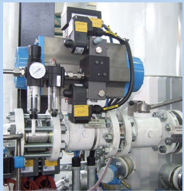
ASC Kugelhahn ATEX mit SIL2 Steuerung ASC ball valve ATEX with coltrol unit SIL2
